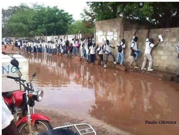
Fig. 15 : Stagnation des eaux de pluies sur la route menant à un collège d'enseignement de la ville de Yaoundé Source : Le quotidien (Mars 2016)
