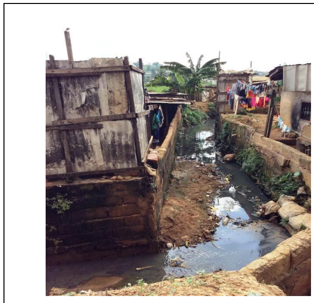
Fig. 19 : Proximité entre toilettes et rigole, quartier Melen-Yaoundé A gauche, une toilette et à droite au fond, deux toilettes traditionnels qui rejettent les déjections directement dans la rigole (milieu naturel)
