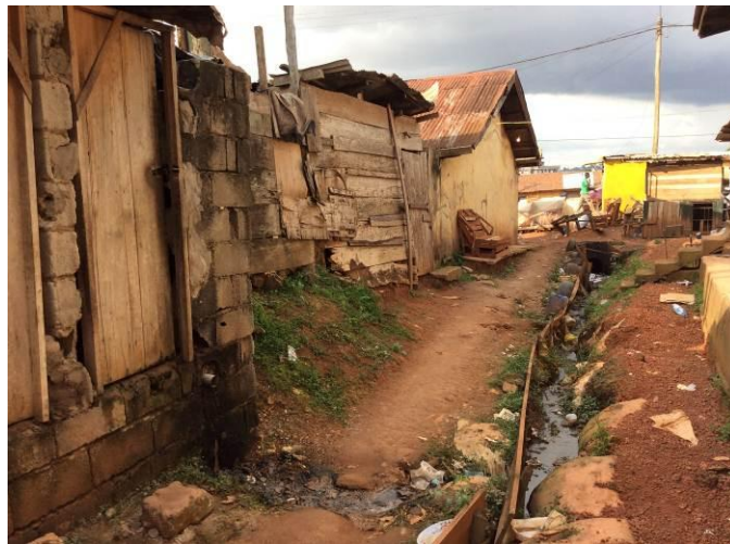
Fig. 7 : Rigole de collecte d'eau pluviale dans un quartier à habitat précaire
