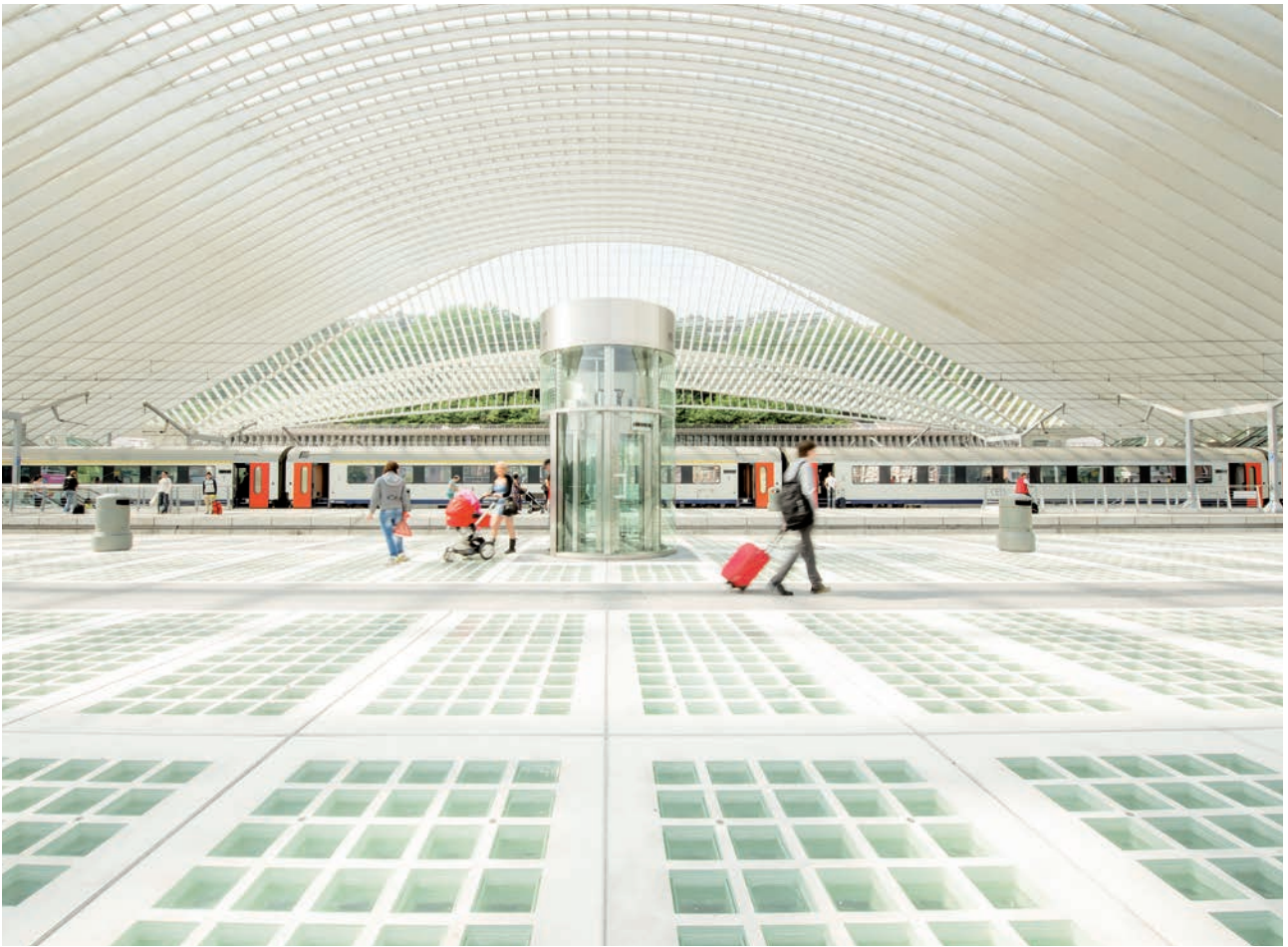
À Liège, une des plus belles gares au monde, véritablement sculptée dans l'espace urbain par Santiago Calatrava.
